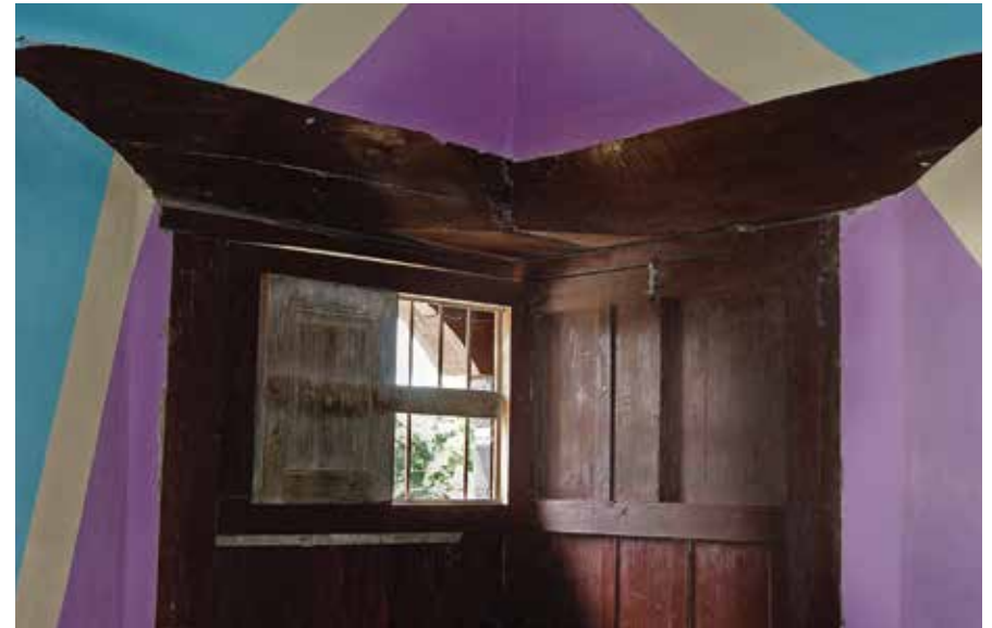
Detalle interior de vivienda tradicional antigua, Erandique, Lempira.
